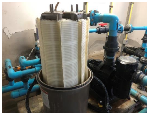
ระบบกรองน้ำสระว่ายน้ำ (ระบบเกล็ด)
